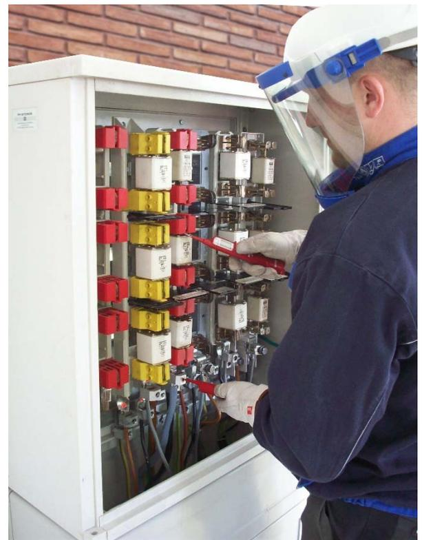
In der Praxis hat sich dabei gezeigt, dass die Störlichtbogenengefahr an Anlagen mit geringeren Kurzschlussströmen häufig unterschätzt wird. Gerade bei langen Kabelstrecken vom Transformator bis zum Arbeitsplatz (z.B. Hausanschlusskasten oder abgesetzte Unterverteilungen) kann die Fehlerdauer durch die verlängerte Abschaltzeit der vorgelagerten Sicherung überproportional stark ansteigen. Im Ergebnis führt dies zu hohen Lichtbogenenergien trotz verhältnismäßig kleiner Kurzschlussströme.
